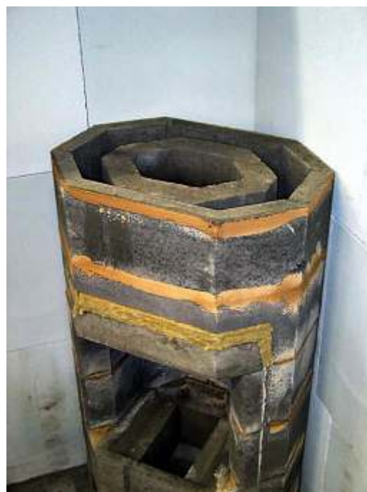
14. Seguga paigalda välimine rõngaselement (nr.8) ja tuletoru element (nr.9). Tihenda vahe tulevillaga(nagu pildil), kontrolli vuugid ja pühi segu jäägid.
