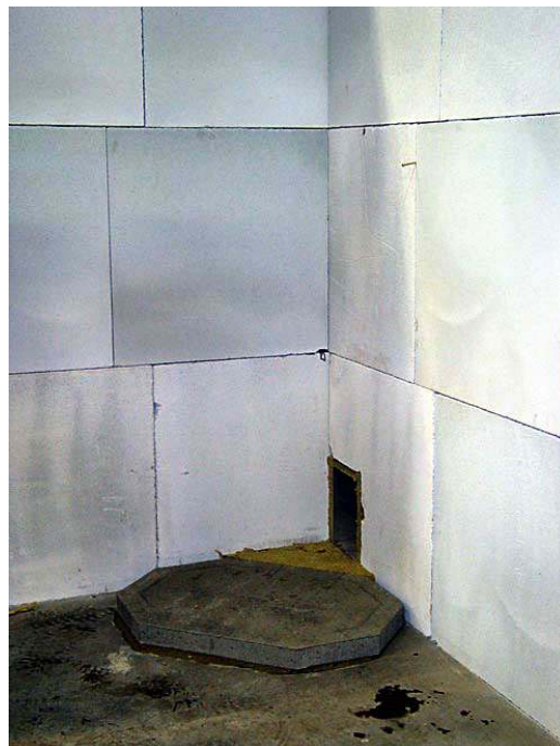
2. Nurgaliitmise korral täida nurka jääv tühimik tulevillaga, nagu pildil.
