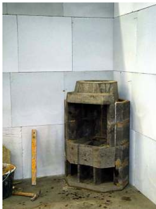
12. Kasutades segu, paigalda tulepesa sobituselement(nr.6).
