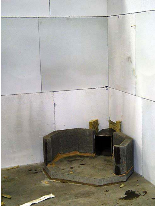
5. Paigalda lõigatud U-element(nr.2) tulesegu peale.
