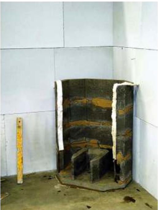
10. Aseta tihendusvilla ribad, nagu näidatud joonisel ja paigalda kolde põhjaelement(nr.4). Kontrolli, et paigaldatud elemendid oleks loodis.
