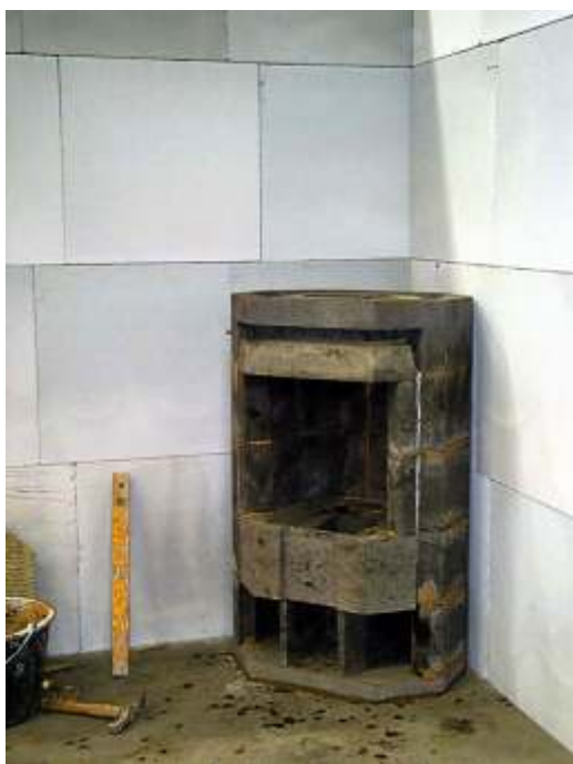
13. Aseta segu ja paigalda lõigatud rõngaselement(nr. 7)
