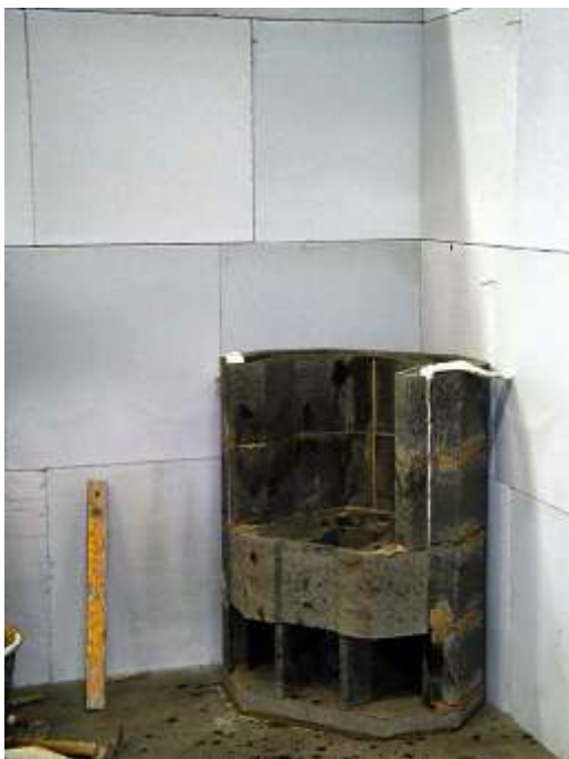
11. Kasutades piisavalt segu paigalda tulepesa elemendid(nr.5) 2+2tk. Ka püstivuugis kasuta segu. Elementide ülaservad peaks olema nüüd ühes tasapinnas.
