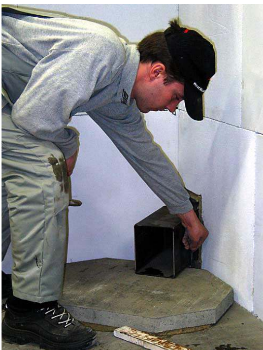
3. Möödista ja märgi liitmistoru vastavalt korstna liitmisega nii, et toru serv on tasa U-elementi(nr.2) sisepinnaga ja läheb ka korstnasse piisavalt sügavale.
