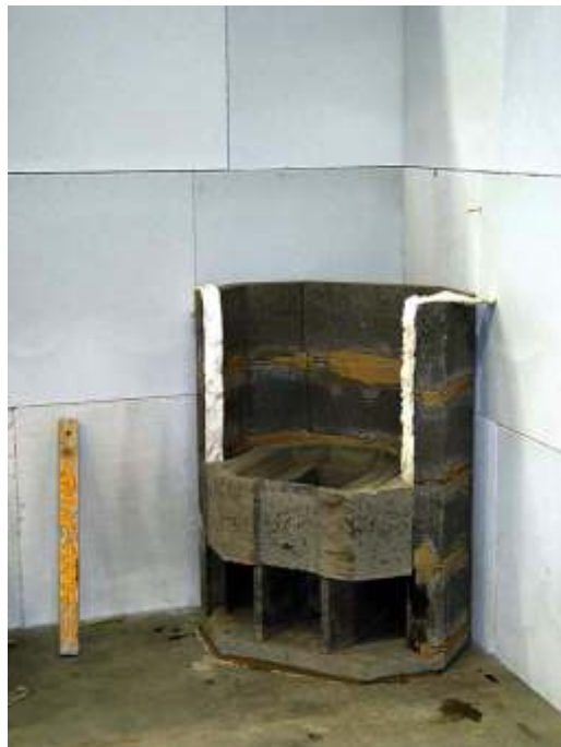
10. Aseta tihendusvilla ribad, nagu näidatud joonisel ja paigalda kolde põhjaelement(nr.4). Kontrolli, et paigaldatud elemendid oleks loodis.
