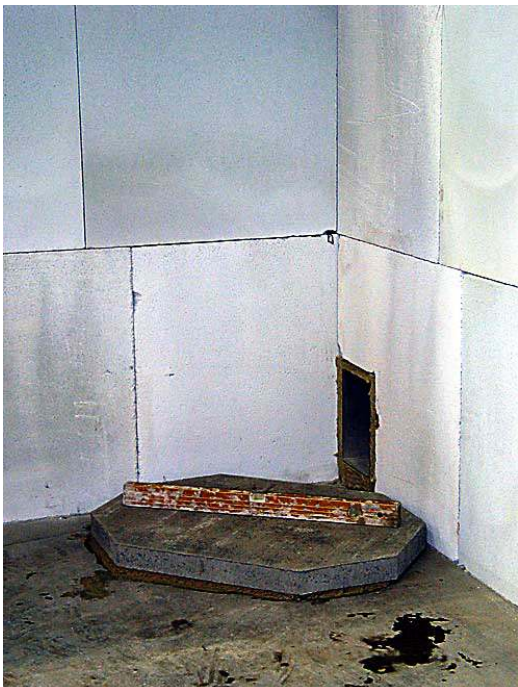
1. Möödista süda paika alusplaadi abil jälgides korpuse müüritise ja südame vahele jäävat vahet. Kontrolli loodi abil, et alusplaat (nr.1) on otse ja loodis. Põhjaplaadi loodimiseks kasuta segu.
