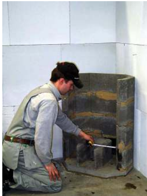
9. Mõõdista, paigalda segu ja aseta tuhasahtli element(nr.3) alusplaadi keskele, alusplaadi esiservaga samale joonele.
