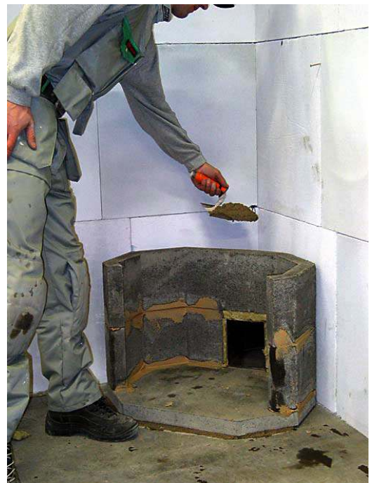
7. Tihenda liitmistoru ahjuelementidega hoolsalt. Isoleeri ka ahju tagant näha jääv liitmistoru villa ja seguga. (Ahju ehitamisel pead villaga tihendama ka väliskoore ja liitmistoru vahed.)
