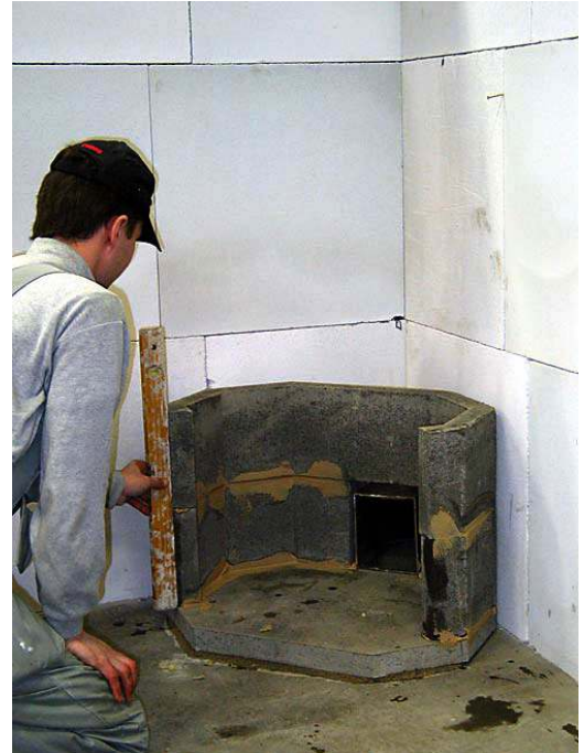
6. Kata eelement pealt seguga ja aseta teine U-element(nr.2) paigale.
