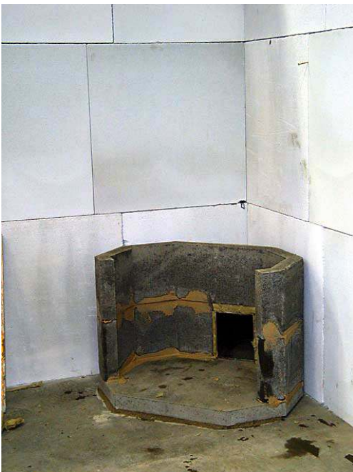
7. Tihenda liitmistoru ahjuelementidega hoolsalt. Isoleeri ka ahju tagant näha jääv liitmistoru villa ja seguga. (Ahju ehitamisel pead villaga tihendama ka väliskoore ja liitmistoru vahed.)
