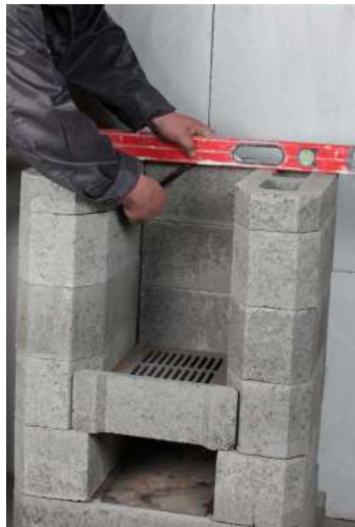
8. Paigalda koldeelemendid jäta madalad koldeelemendid viimaseks. Vajadusel löika viimane tagaseinaelement küljeelementidega ühekõrguseks.
