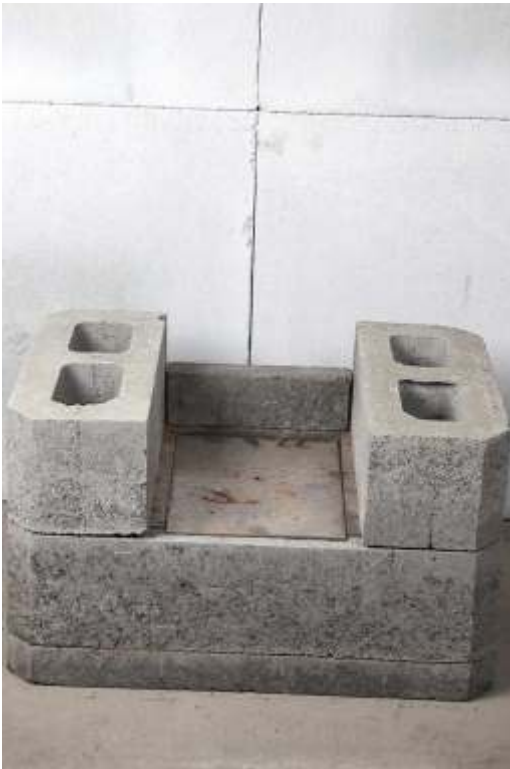
5. Paigalda täisnurgaga küljeelemendid ja madal tagaseina element. Ära unusta kasutamast piisavalt tulesegu!
