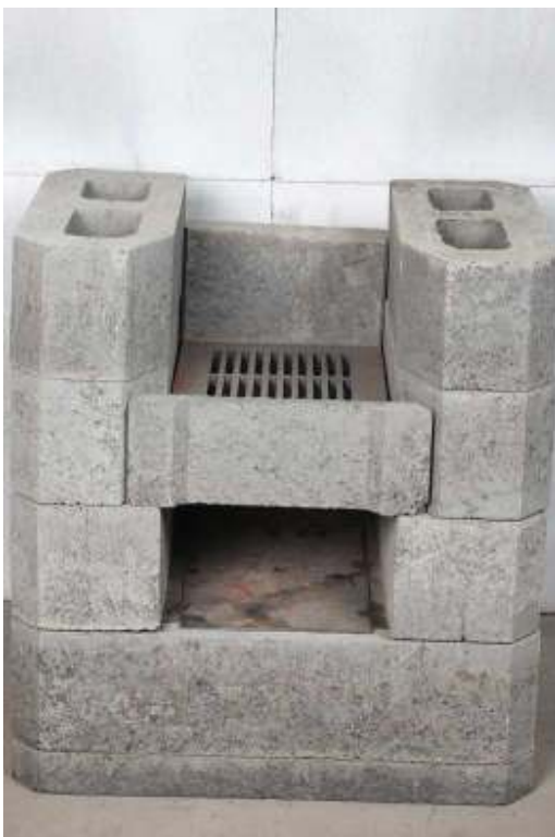
7. Aseta paika kolderesti kandur ja kontrolli, et kolderest istub ilusti pesas. Paigalda järgmised koldeelemendid.
