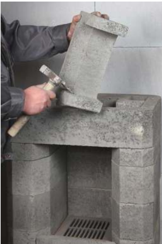
9. Paigalda rõngaselement. Puhasta tulepesa sobituselement hoolsalt enne paigaldust.
