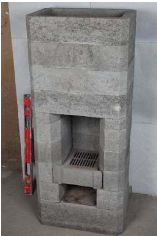
11. Paigalda kõik rõngaselemendid. Kontrolli, et südame kõik küljed on otse.
